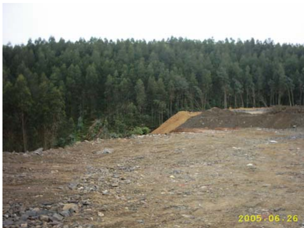
Plataforma de vertidos y talud de avance N°-5
