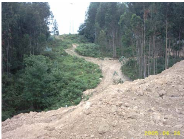
Plataforma de vertidos y talud de avance Nº-9
