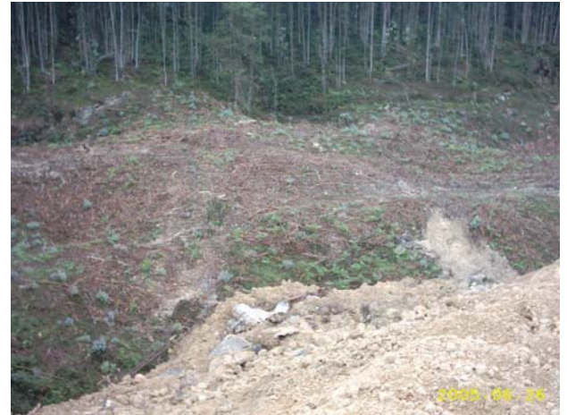
Plataforma de vertidos y talud de avance Nº-8
