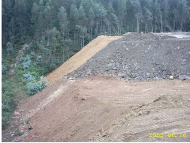
Plataforma de vertidos y talud de avance Nº-7
